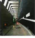
所在地/千葉県 竣工日/2019年7月9日
