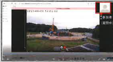
Safieによる現場ライブ中継 (現場全景)
