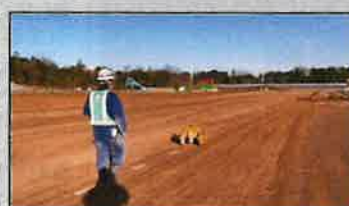
マーキング作業状況
