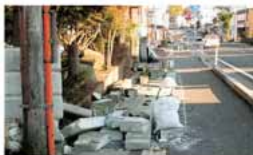
ブロック塀の倒壊（新潟県中越地震時の新潟県小千谷市）
