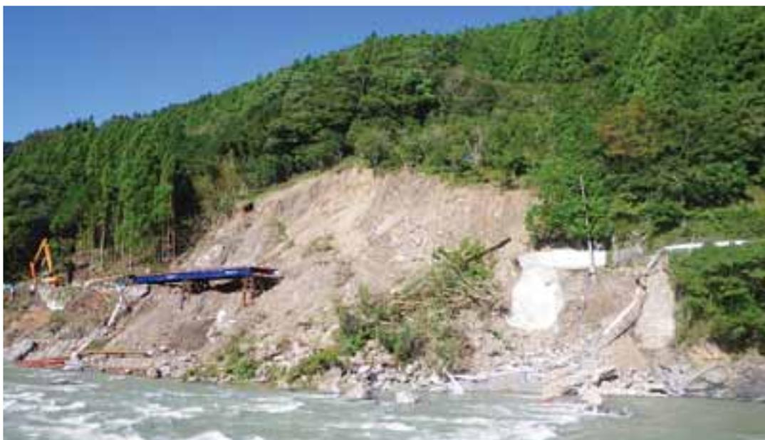
緊急復旧工事で仮橋を設置中
